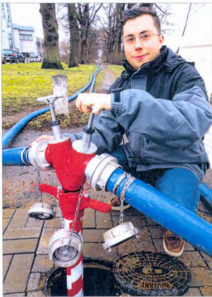
Oliver Bolzmann hat die Rohrputzaktion von Roggenhorst bis Moislung geplant. Jetzt muss er nur noch den Hahn für die alternative Wasserversorgung aufdrehen, damit im Herrenholz keiner auf dem Trockenen sitzt.
